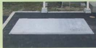
アスファルト
